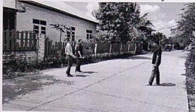
๑. โครงการก่อสร้างถนนคอนกรีตเสริมเหล็ก ถนนสายศาลปู่ตา บ้านท่าหว้า หมู่ที่ ๓
